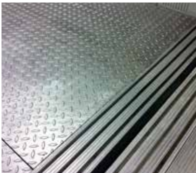
Detalle del suelo estriado
